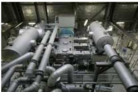
Figure 8.1 – Bouteilles antipulsatoires et réseaux gaz
