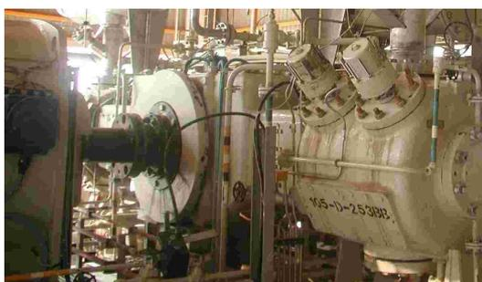
Figure 6.1 – Ligne d'arbres de compresseur alternatif
