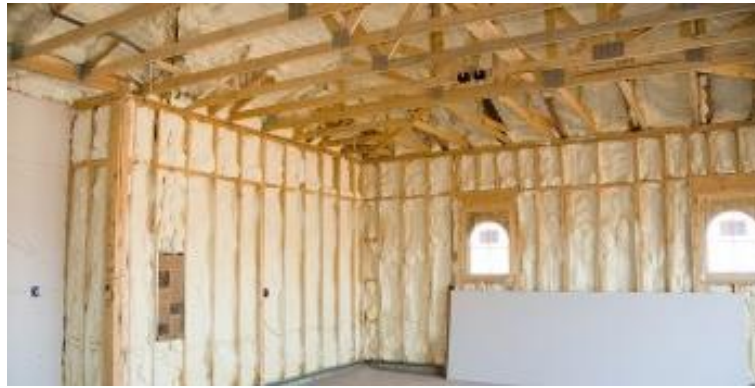
Fig. 5 – Isolation d'un bâtiment avec mousse polymère
