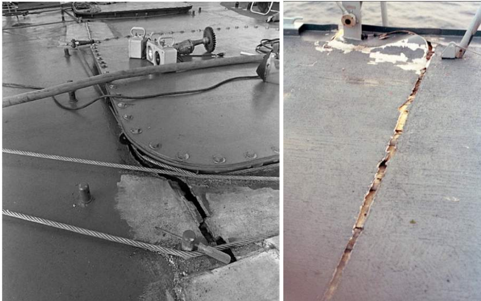
FIGURE 4: Propagation d'une fissure sur le pont de l'USS Samuel B. Roberts.
