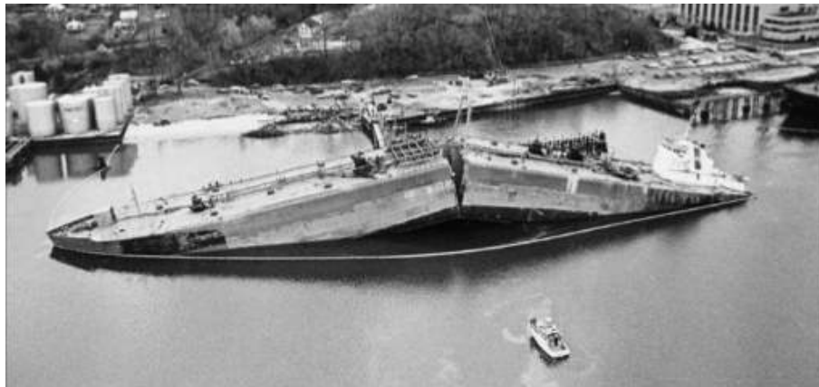
FIGURE 1.3: Photographie d'un Liberty ship dont la coque est rompue en deux.
