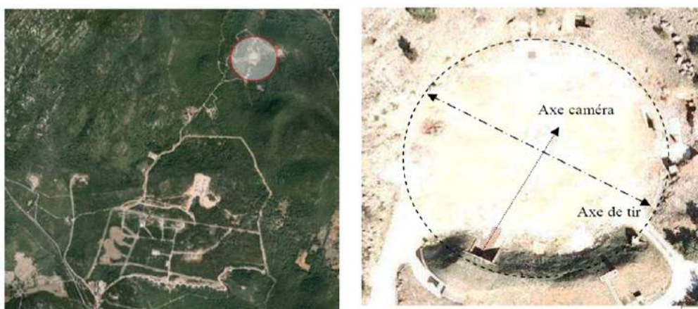
FIGURE 3.42: Vue aérienne du site DGA Tourris.
