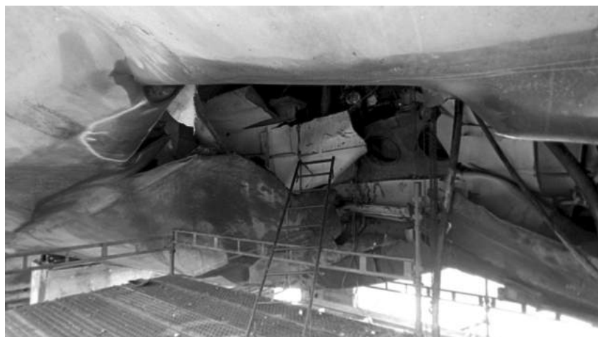
FIGURE 3: Dégâts causés par la mine sous la coque de l'USS Samuel B. Roberts.
